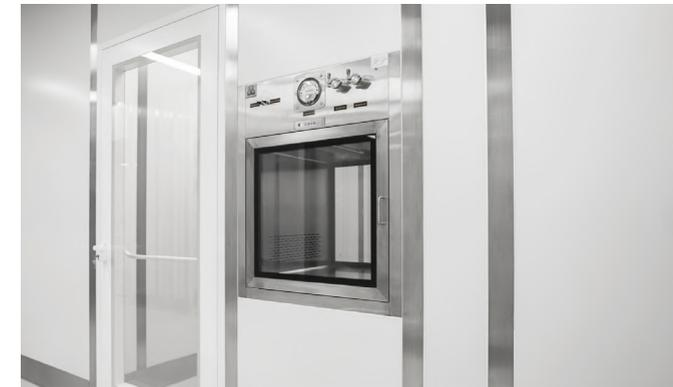
Передаточный бокс. Все коммуникации оборудования сверху и снизу закрыты стеновыми панелями
