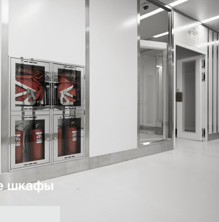
Пожарные шкафы интегрированы в стену чистых помещений и составляют единую плоскость стены
