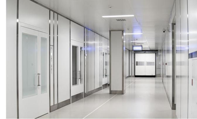
Металлическая колонна здания в коридоре закрыта панелями
