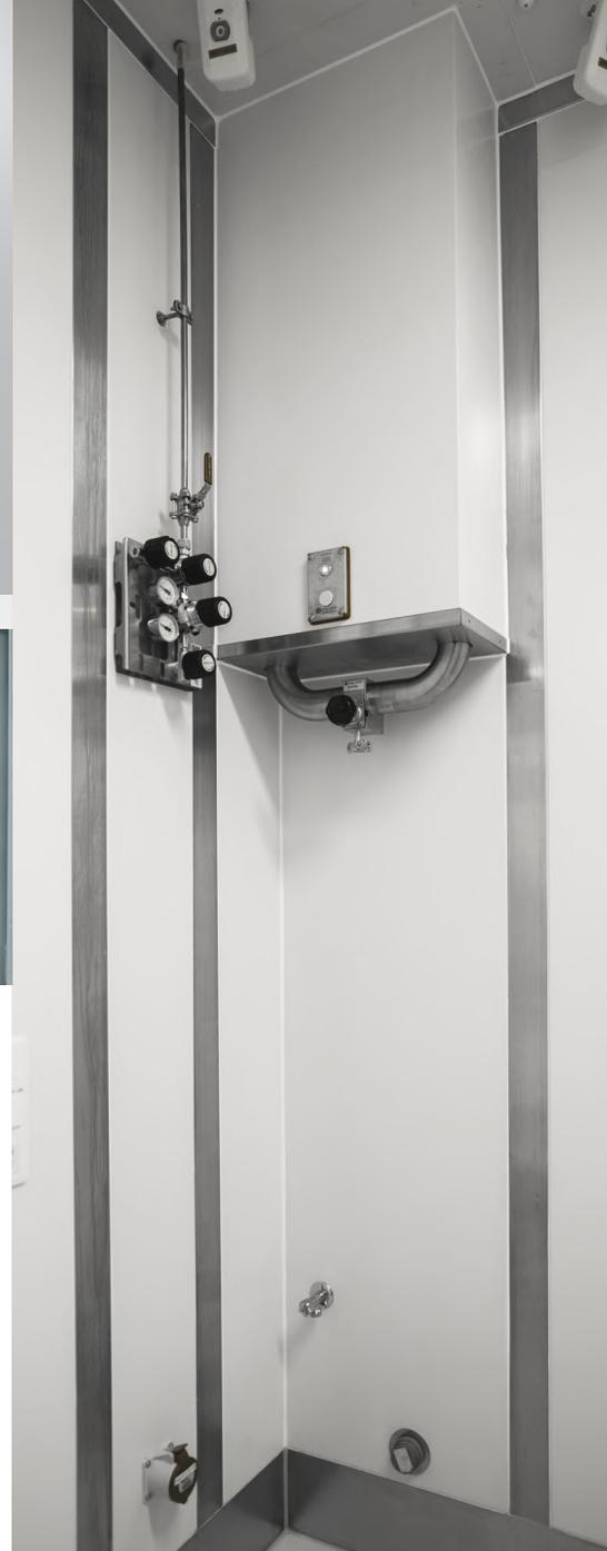
Опуск петли WFI-воды закрыт стеновыми панелями
